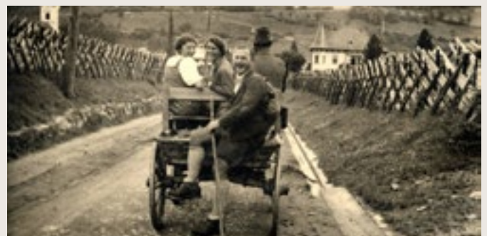
Der Fahrweg von Klausen zum Markt, für eine Wassereinleitung im Falle eines Marktbrandes sichtlich gut geeignet
